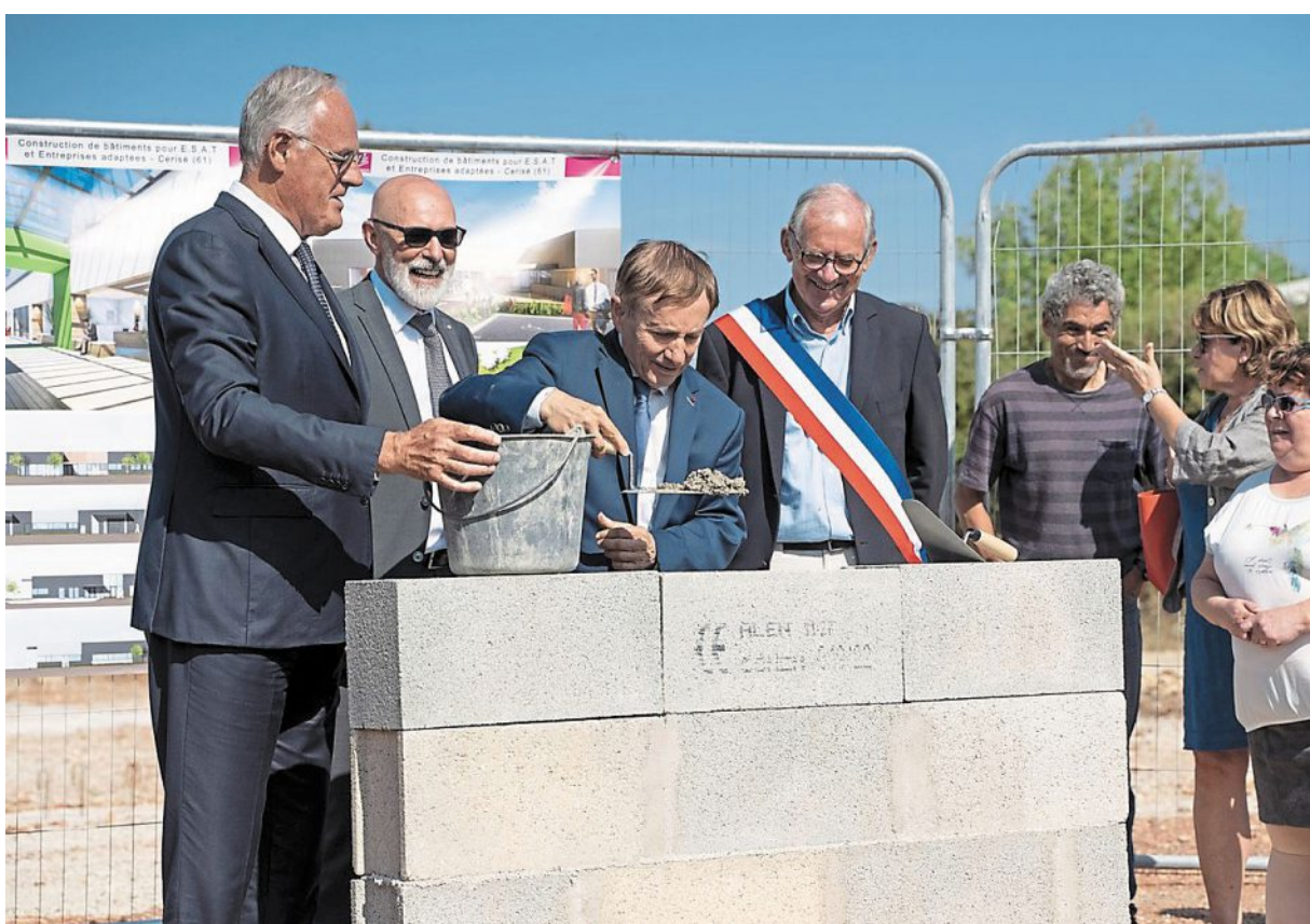
Le début des travaux du futur bâtiment de la fondation Anais a été officialisé mardi.
